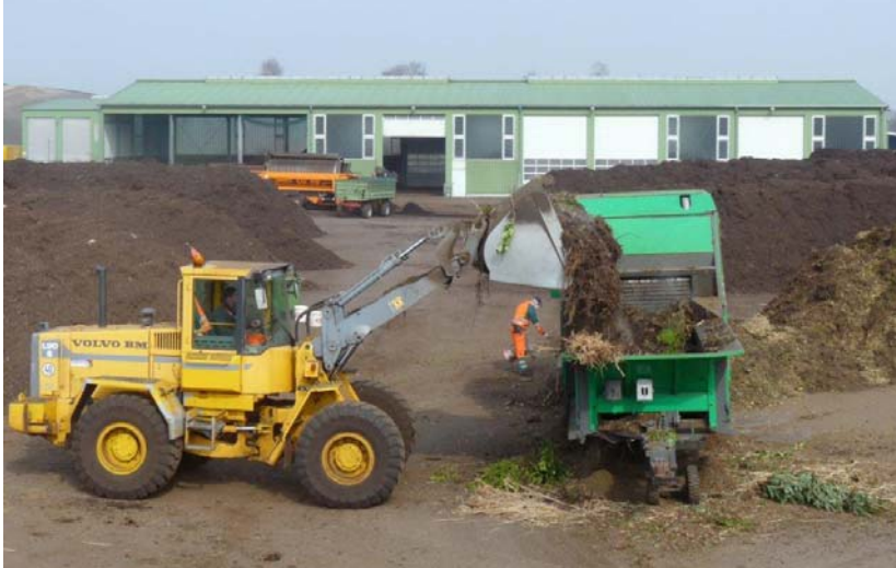
Auf den Dächern des Kompostwerks (Bild) und der Abfallumschlaganlage soll eine Photovoltaikanlage installiert werden.
