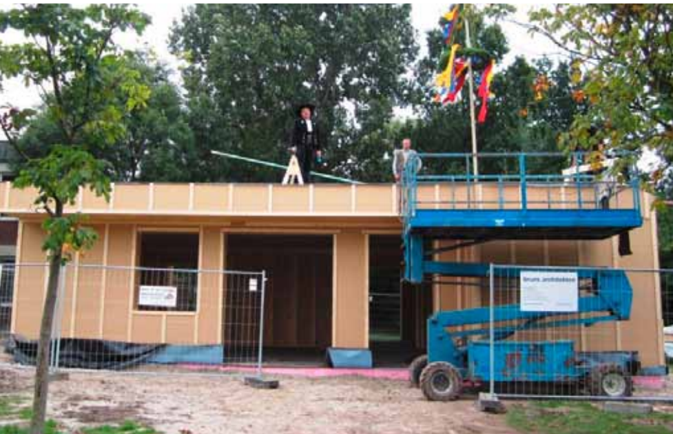
Die BBS-Tagespflegestelle wird als Niedrigenergiehaus errichtet.
