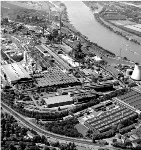
umgewandelt. Hierbei wird der im Roheisen enthaltene Kohlenstoff durch Aufblasen von reinem Sauerstoff verbrannt. Der Rohstahl, der mit einer Temperatur von ca. 1750°C anfällt, wird anschließend in modernen Stranggussanlagen zu Brammen und Röhrenrundmaterial vergossen.
