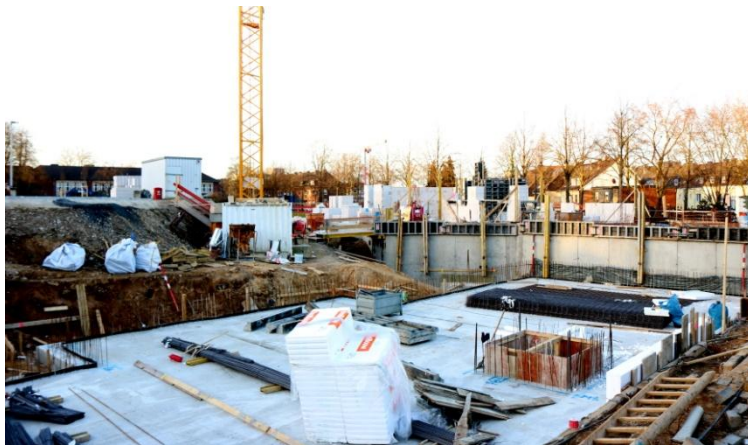
Baustelle des Quartiers Lücker Stein in Viersen Foto: Kreis Viersen.
