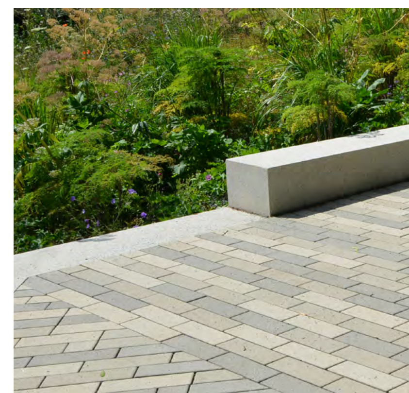
Mehrfarbiges Betonpflaster mit Natursteinvorsatz, Riemchenformat
