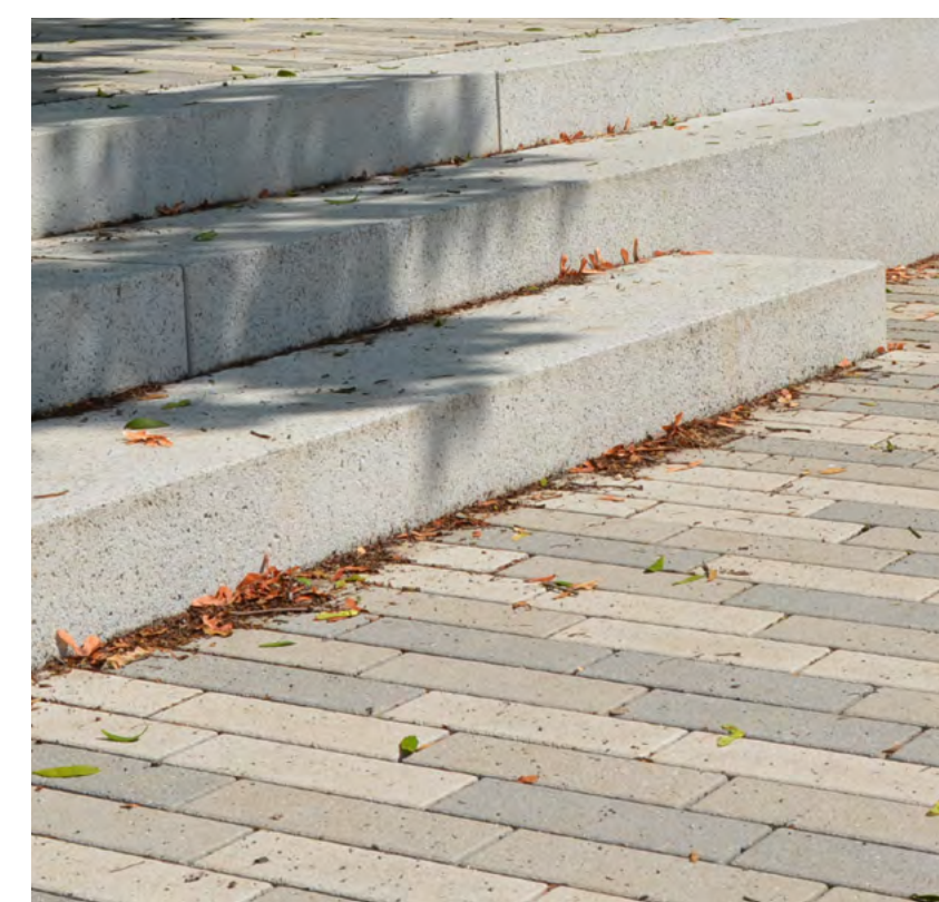
Betonfertigteile durchgefärbt und stahlsandgestraht
