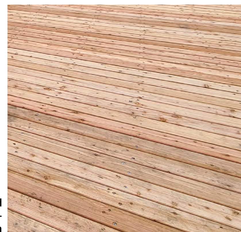
Balkon bestehend aus einer Stahl-Holzkonstruktion
