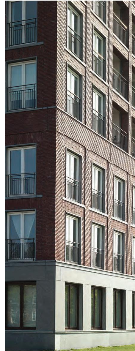
Sockelzone, Reliefierung Kollhoff & Pols architecten, Breda
