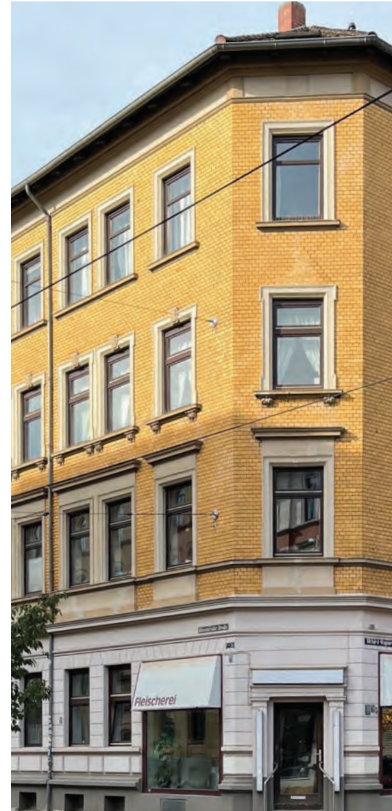
Dachrand Fries aus Putz, Überstand
