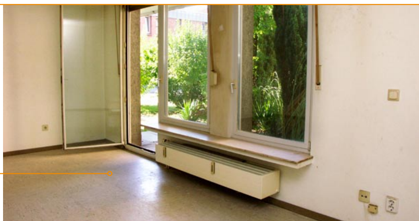
Wohnraum im Rohzustand, vor Renovierung und Ausstattung
