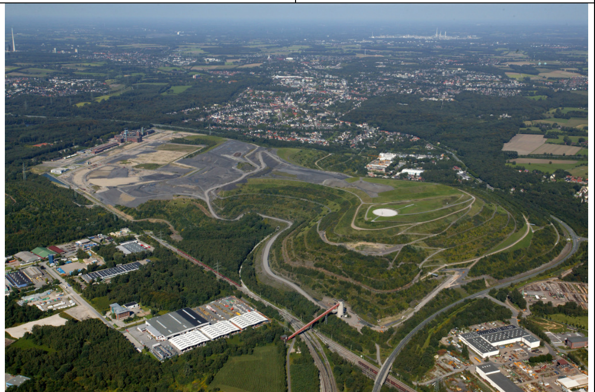
Landschaftspark Emscherbruch: Blick in Richtung Norden. Halde Hoheward mit Obelisk und Sonnenuhr, Projektfläche (links), Bahnanschluss (untern), Stadt Herten und Chemische Werke Hüls im Norden (09.09.2006)
