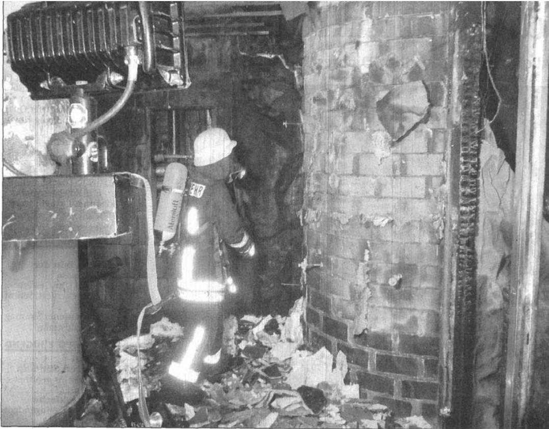
Ein Scheinwerfer erhellt den ausgebrannten Bereich der Tropensauna. Um die Glutnester löschen zu können, mussten die Feuerwehrleute die Wandverkleidung von den Mauern reißen.
