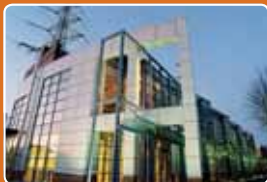
Lehrreiches und Kurioses zum Thema Strom präsentiert das Umspannwerk Recklinghausen.
