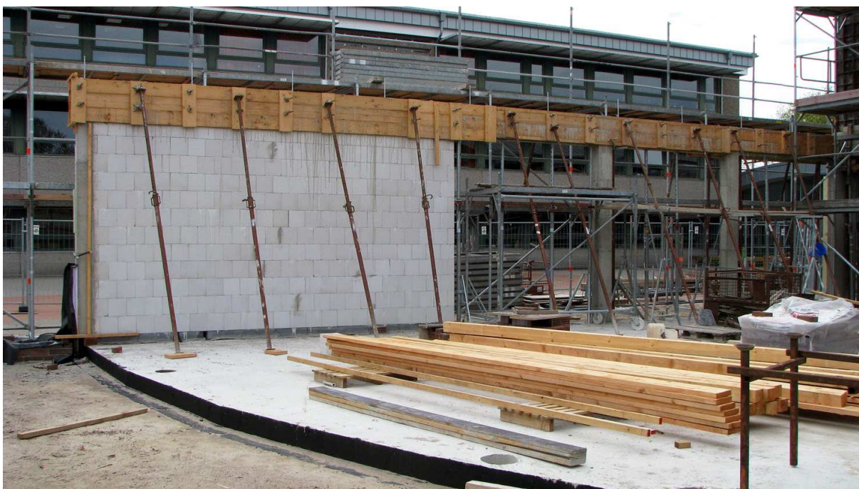
Die Arbeiten an der Mensa beim Schulzentrum Rhaderfehn schreiten voran.
